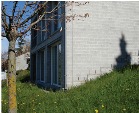
Einbettung der Baute in den Hang: Das Terrain bleibt erlebbar, das Erdgeschoss weist einen kleinen Austritt auf.
