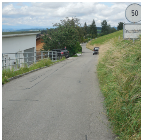
Sichtberme: Strassensituation Richtung Westen
